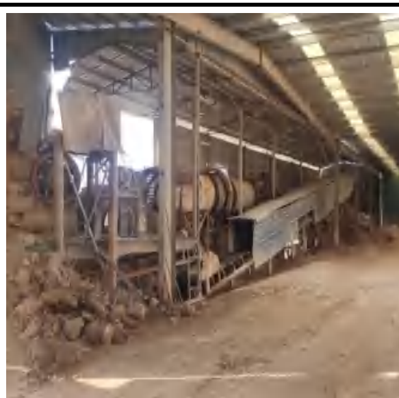
现有工程水洗砂生产车间
