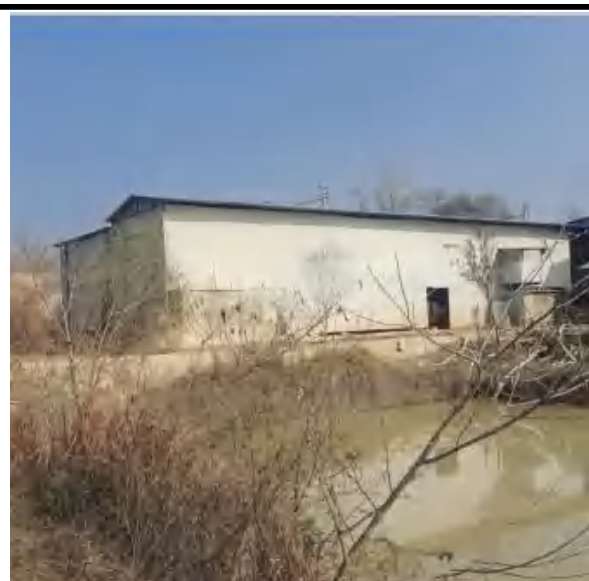
现有工程水洗砂生产厂房
