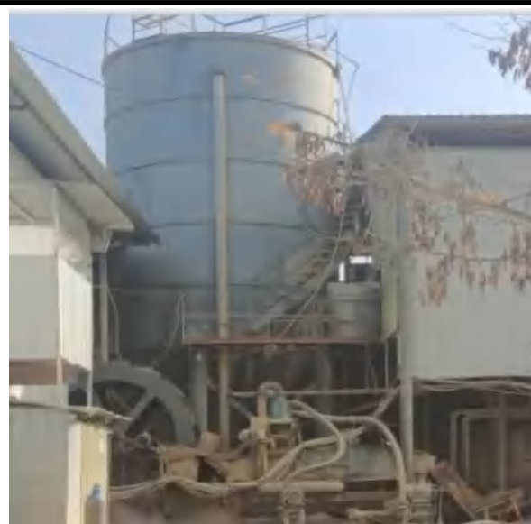
现有工程沉降罐
