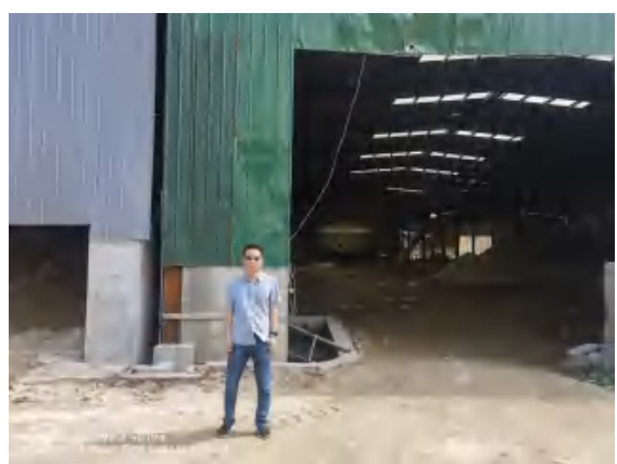
工程师现场勘查照片
