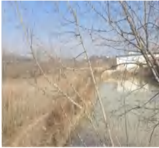
项目厂区西侧
