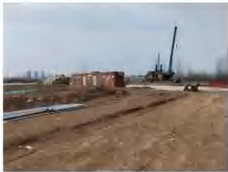
项目选址现状
