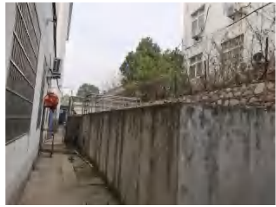
现有污水处理站
