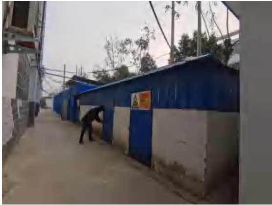
现有危废暂存间
