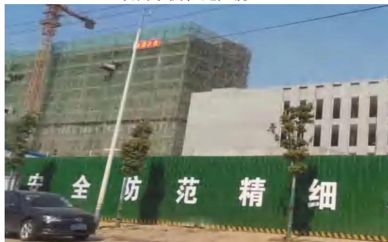
项目西侧在建厂房
