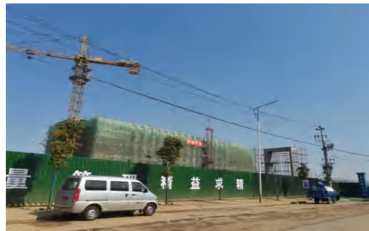
项目东侧在建厂房
