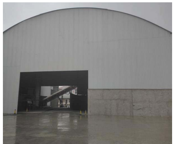
项目现状照片2
