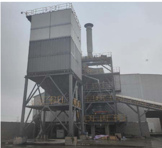
项目现状照片1
