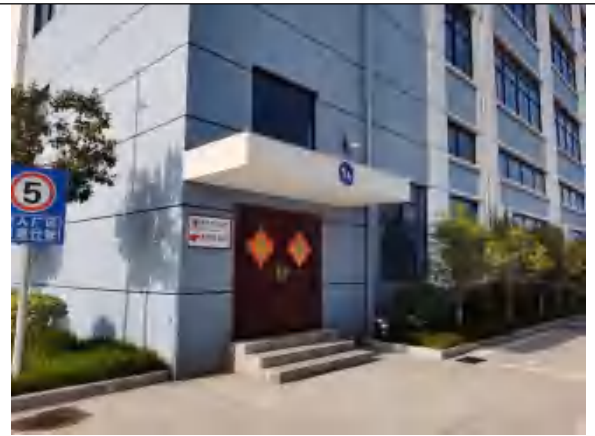
厂房南侧 1 号楼现状
