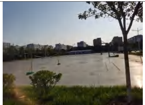
厂房西侧现状 (娱乐场)
