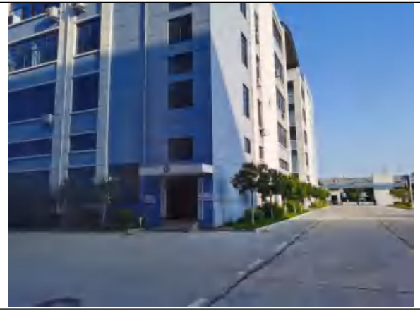
厂房所在楼 2 号楼现状
