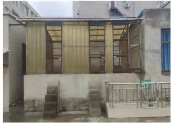
院区污水处理站
