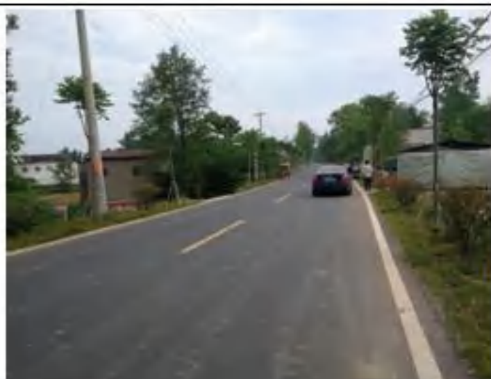
项目东侧道路
