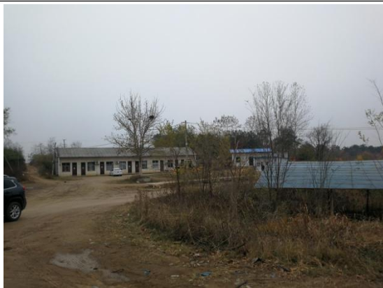
项目东侧依托办公室
