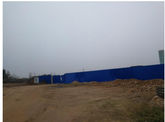
项目南侧运输道路
