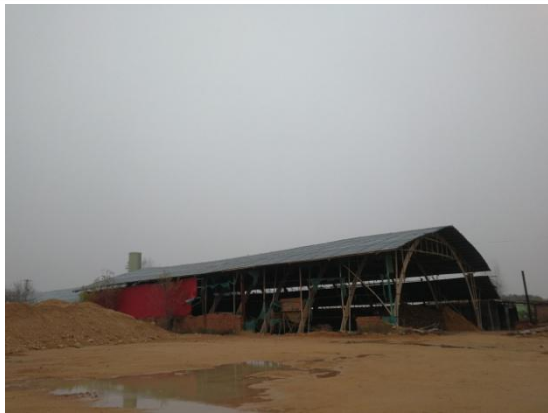
项目南侧原砖厂生产车间
